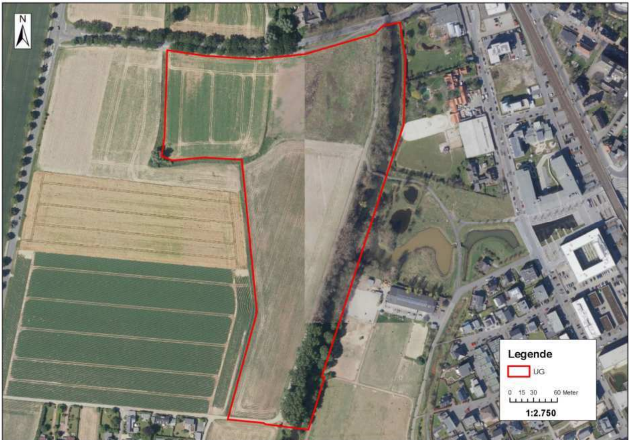
Abbildung 23: Bestandssituation des künftigen Niershafens
