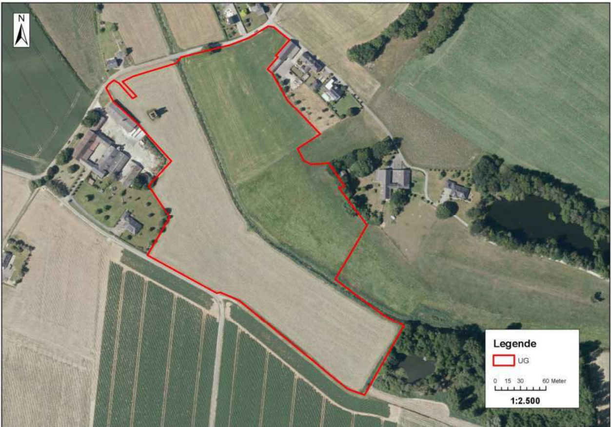
Abbildung 32: Bestandssituation im Bereich des Turmstumpfes Haus Langendonk
